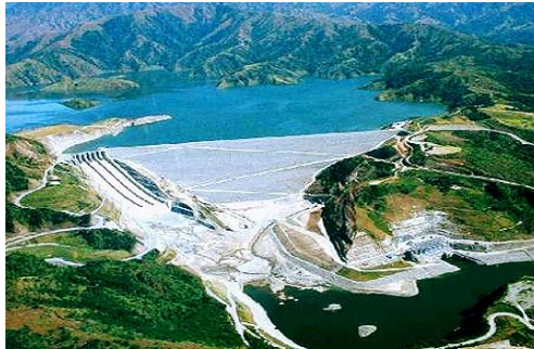
345MW San Roque Hydro (Pangasinan)
